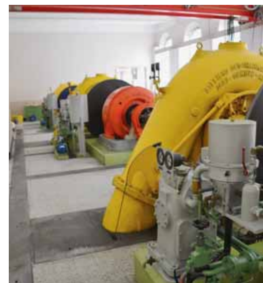
Les trois turbines (datant de 1927) du Plan-de-l'Eau.
