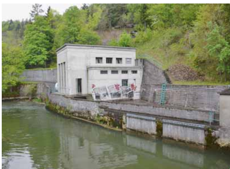
La centrale du Furcil: le mur à gauche est l'amenée d'eau vers la turbine.
